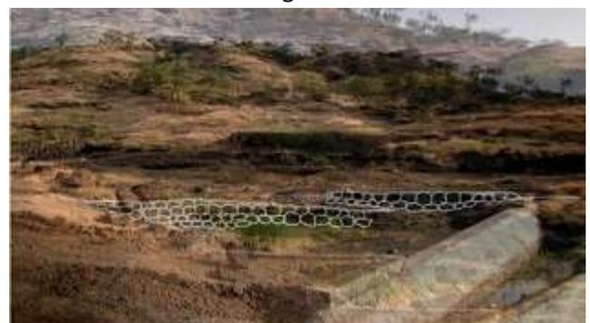
Dessin des barrages (johads, retenues ...), des gabions (casier constitué de solides fils de fer tressés et rempli de pierres, pour construire des murs de soutènement,
