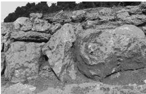
Blocs métriques à la base de la murette, permettant sa stabilité et l'évacuation des eaux en excès
