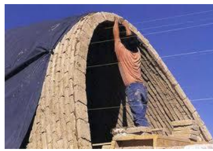
Maisons réalisées par la technique de la voûte nubienne
