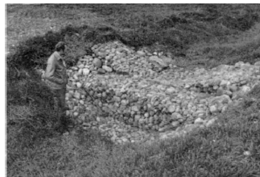
La chute en arc de cercle fait franchir à l'eau une dénivellation importante sans provoquer d'érosion.
