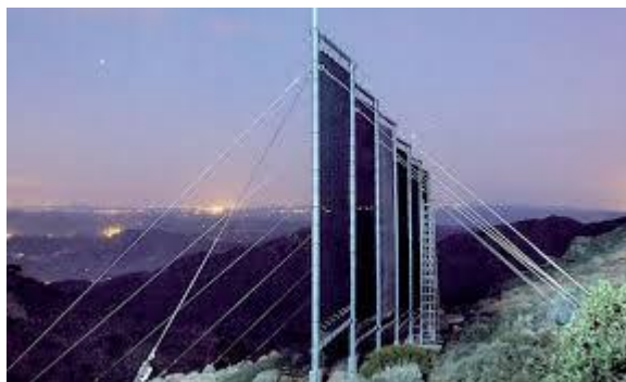
Le projet est composé de 600 m 2 de filets capteurs, deux citernes de 500 m 3 , un puits de forage, 9.000 m de canalisation et 20 branchements domestiques, au sommet du Boutmezguida (Maroc). Source : http://www.lematin.ma/journal/2015/pour-remedier-au-manque-d-eau-sidi-ifni-moissonne-le-brouillard/226280.html
