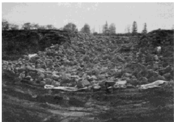
Le déversoir empierré absorbe l'énergie de l'eau en mouvement
