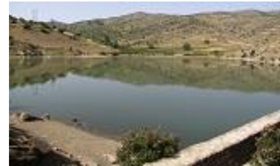
Lac collinaire dans la région nord Marocain installé pour contrer le problème d'envasement d'un barrage en aval. Source : Erosion hydrique, http://www.ma.auf.org/erosion/chapitre1/VI.Lutte.html
