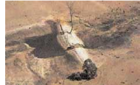
Barrage détruit à cause d'un déversoir [« spillway »] insuffisant.
