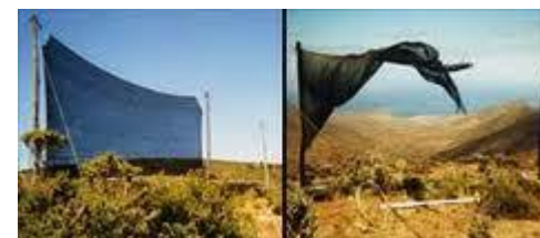
Il faut que les filets soient solidement arrimés au sol. Des filets à nuages sur la crête d'El Tofo (Chili) [un mauvais choix], Stephen Dale, IDRC, http://www.idrc.ca/FR/Resources/Publications/Pages/ArticleDetails.aspx?PublicationID=686
