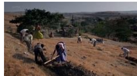
Creusement de la baissière ou du canal.
