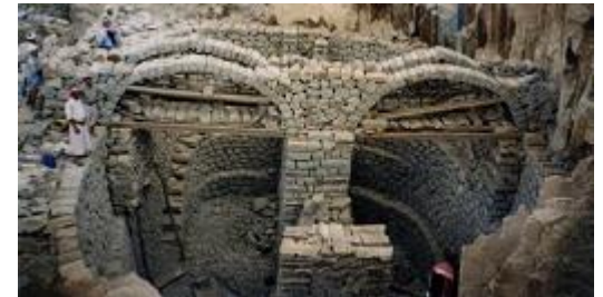
Construction d'une citerne en Syrie
