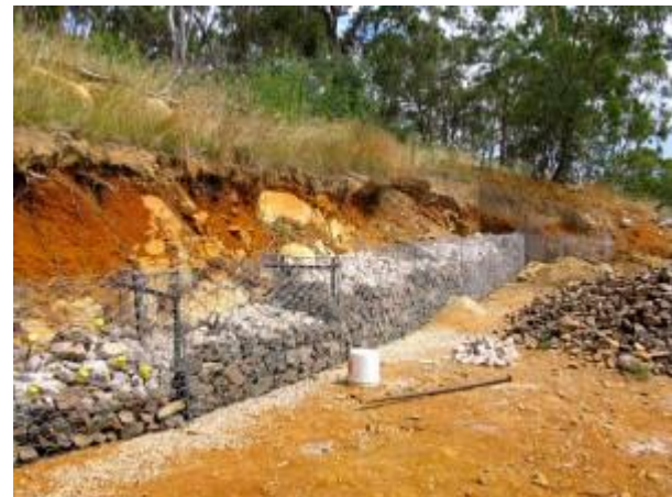
Remplissage avec des cailloux, source Milkwood Permaculture
