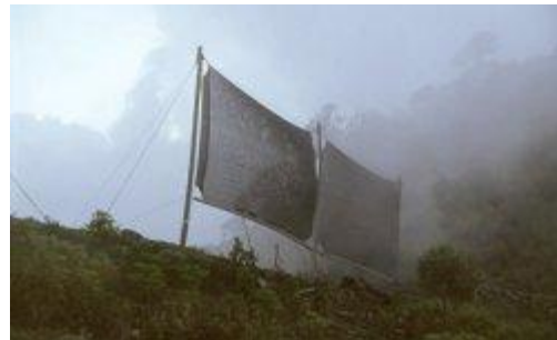
Un filet à brouillard installé dans le village de Danda Bazzar (Népal), à 2130 mètres d'altitude. Les filets alimentent trois réservoirs de 1000 litres.
