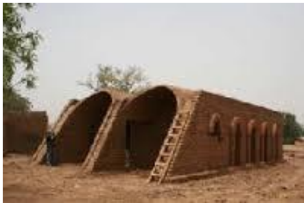
Maisons réalisées par la technique de la voûte nubienne
