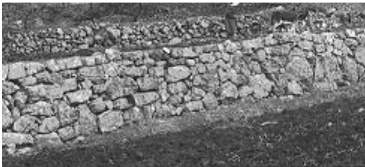
Murette permettant l'irrigation par gravité de la parcelle aménagée
