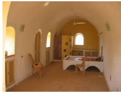
Maisons réalisées par la technique de la voûte nubienne
