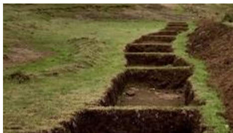
Creusement de sortes de baissières.
