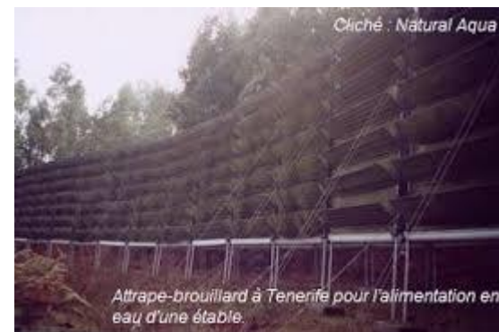
Attrape-brouillard à Tenerife, pour l'alimentation en eau d'une étable, Source image : http://www.clubdesargonautes.org/faq/arbrefontaine.php
