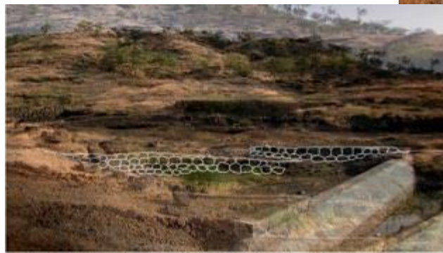
← Dessin des barrages (johads, retenues ...), des gabions (casier constitué de solides fils de fer tressés et rempli de pierres, pour construire des murs de soutènement,
