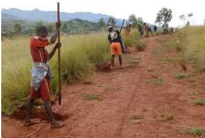
Les travaux avancent vite (© Benjamin Lisan)
