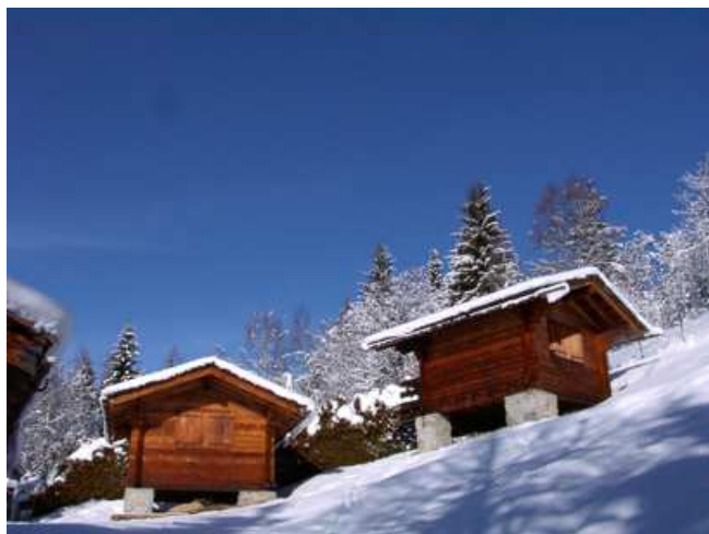
Bungalows pour accueillir les retraitants à la Flatière
