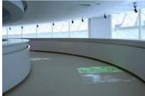
Rampe au musée du Quai Branly.
