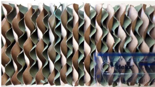
Figure 5. Panneau alvéolaire (en carton) sur lequel l'eau de mer circule et s'évapore.
