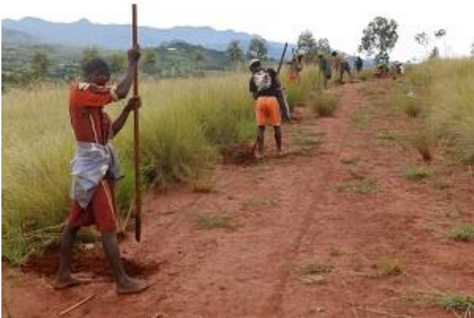
Les travaux avancent vite (© Benjamin Lisan)
